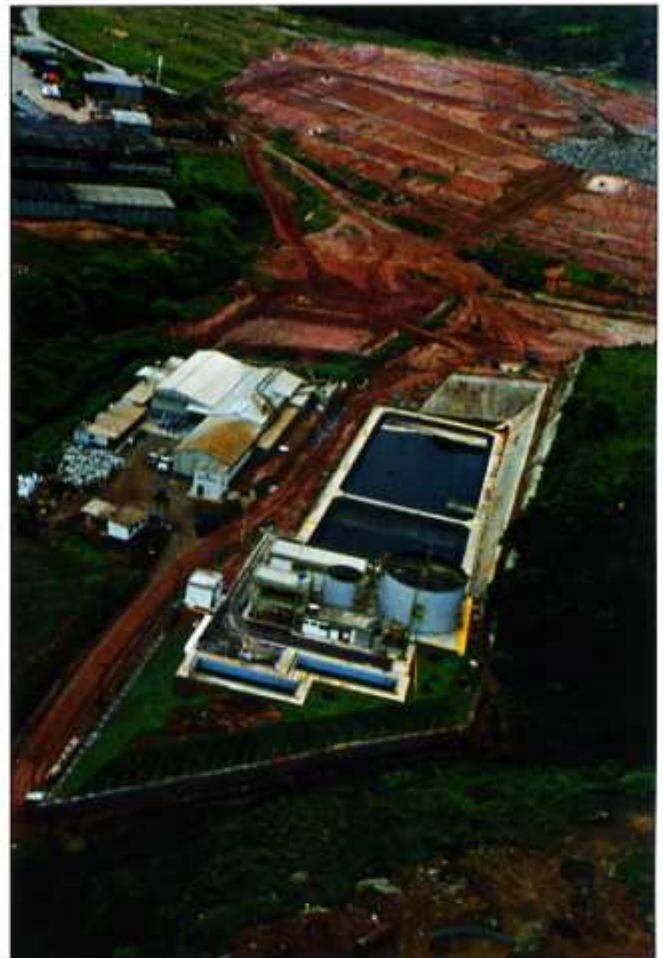
Aterro Sanitário da Lara - Mauá (SP) e Estação de Tratamento de Chorume.
