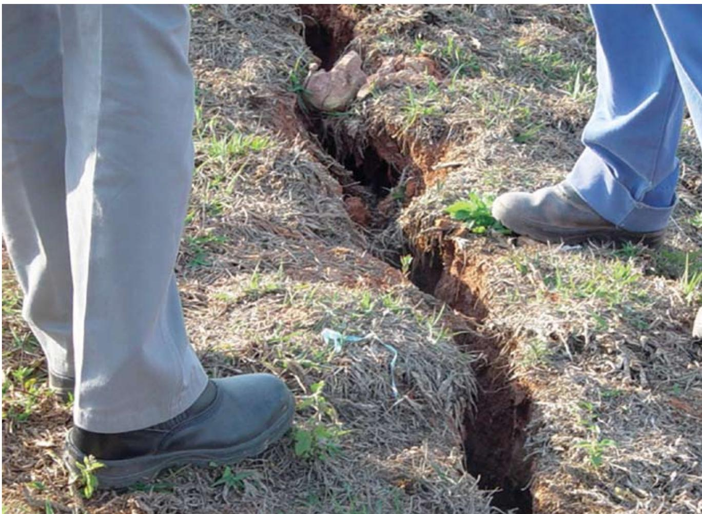
Foto 6 – Trinca em aterro sanitário observada em inspeção técnica
