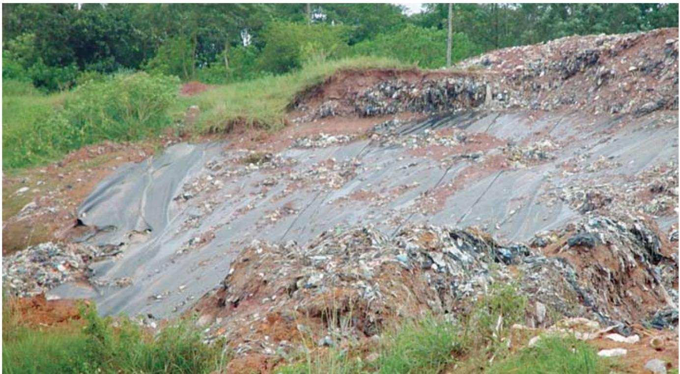
Foto 7 – Geomembrana instalada sobre resíduos, descoberta após rompimento do Aterro Sanitário de Itapequerica da Serra, SP (2006)
