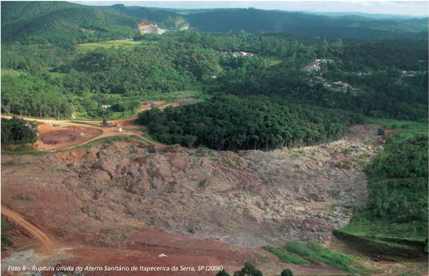
Foto 8 – Ruptura úmida do Aterro Sanitário de Itapeceira da Serra, SP (2006)
