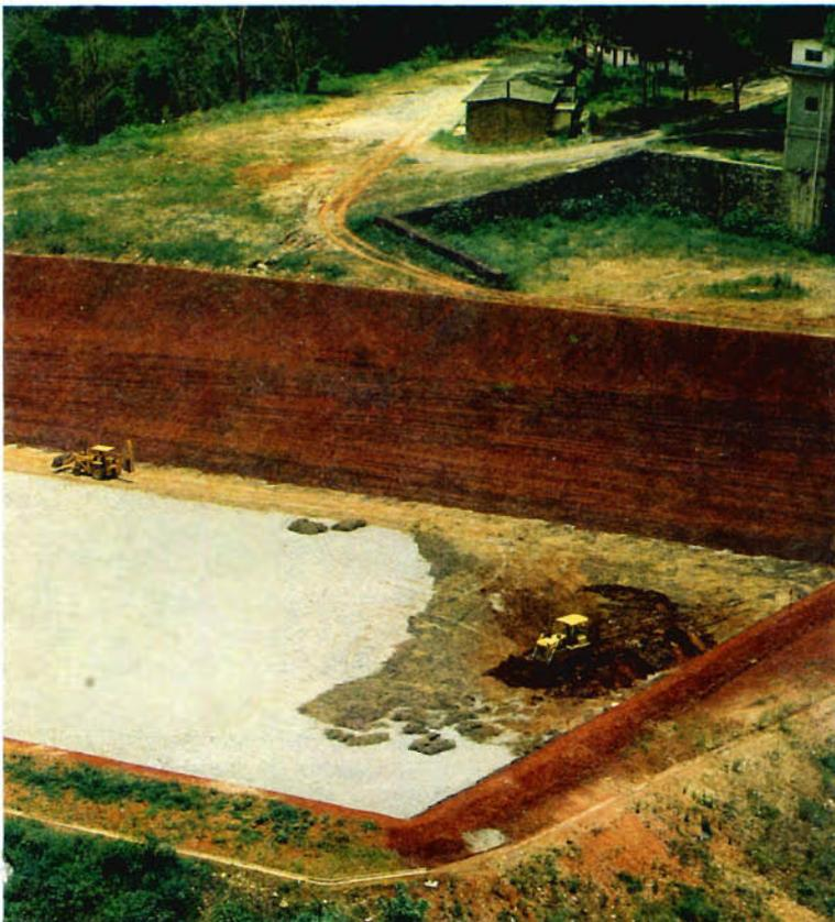
da forma mais segura. Construído no perímetro urbano da Cidade de São Paulo, especificamente na Vila Brasilândia, Zona Norte, o Aterro Industrial de Itaberaba tem 2 milhões de metros cúbicos de capacidade volumétrica, dispostos em fases distintas separadas por camadas de impermeabilização e drenagem, eliminando assim o risco de infiltração no solo e, posteriormente, contaminação do lençol
